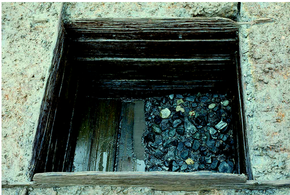
蒸籠組みの井戸は、四隅に柱を使わずに蒸し器の蒸籠のように木を組み合わせて作っています。
